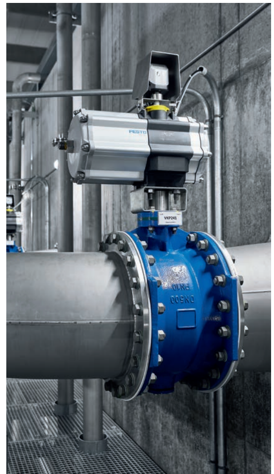
Veloces, limpios y seguros: actuadores giratorios DAPS con posición inicial definida al no recibir corriente eléctrica, recuperan esa posición en caso de un corte de corriente.
