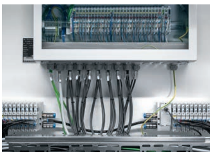
Montaje más veloz: con IO-Link® (izq.) es posible prescindir del cableado individual de las válvulas, lo que simplifica considerablemente la instalación eléctrica.
