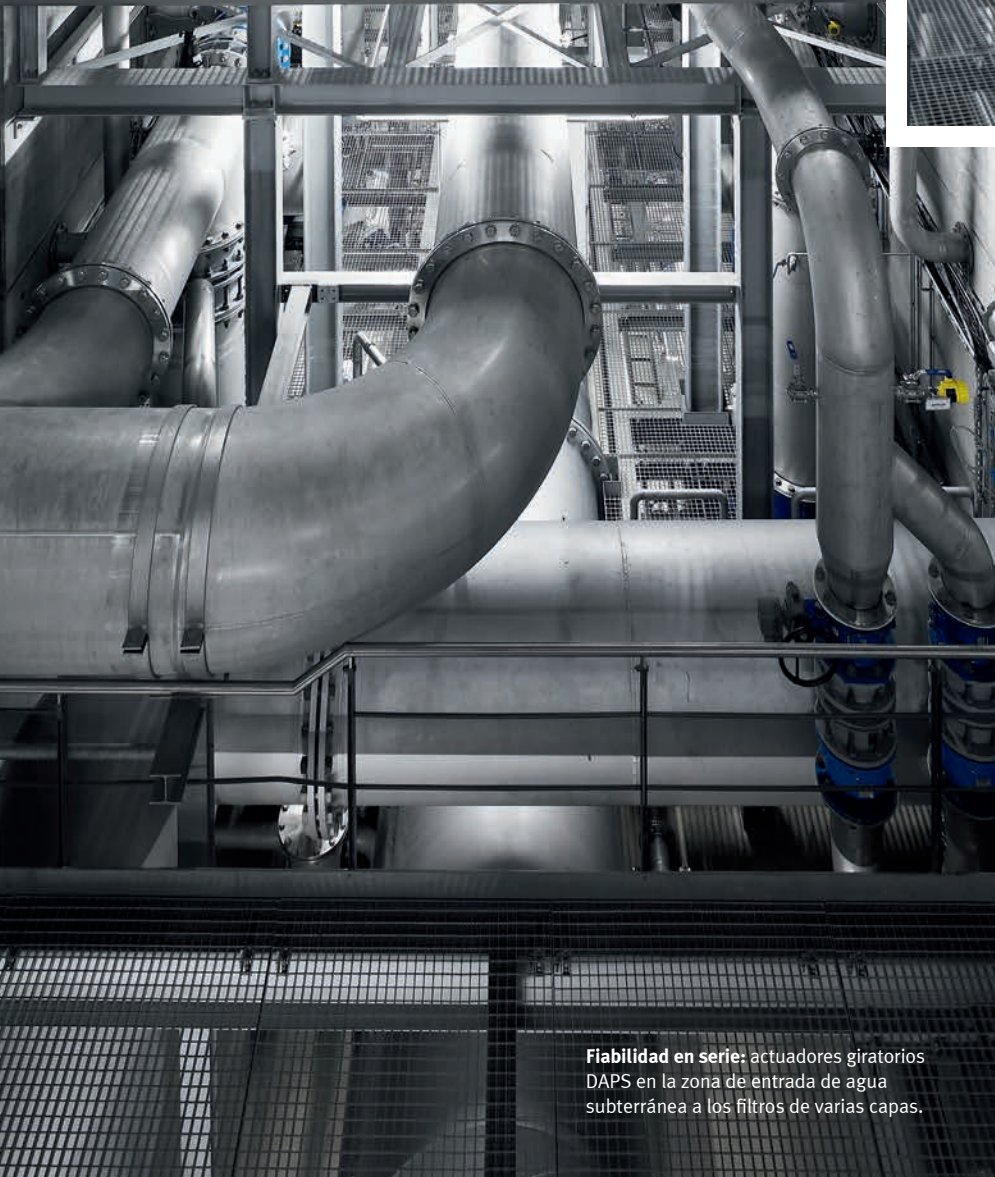
Veloces, limpios y seguros: actuadores giratorios DAPS con posición inicial definida al no recibir corriente eléctrica, recuperan esa posición en caso de un corte de corriente.
